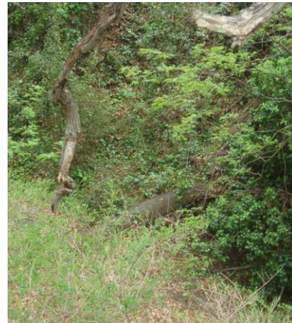
Encombrement des évacuations d'eau
