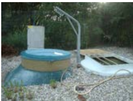
Premières cuves récupératrices
