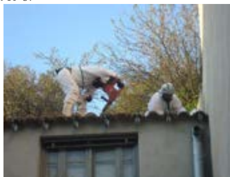
Travaux de désamiantage de la toiture
