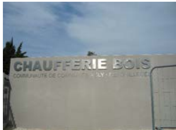
Entrée de la chaufferie
