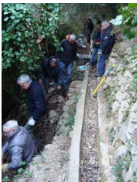
Restauration des canaux d'irrigation
