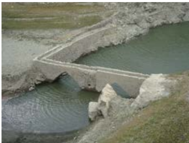
Ancien aqueduc d'irrigation de l'Horto
